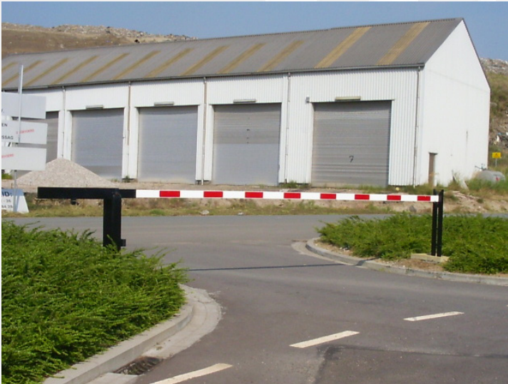
Handbediende slagboom met vaste steunpaal en rok onderzijde
